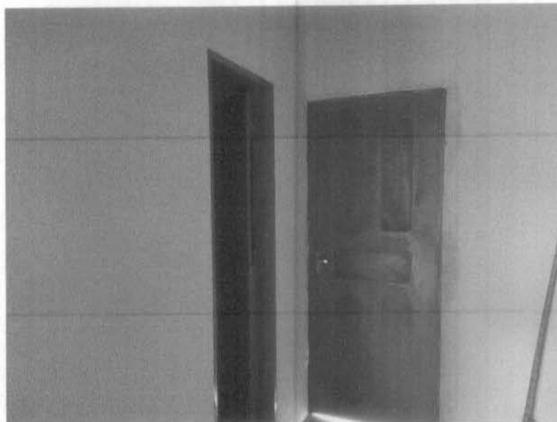
Imagem 03 – Troca de esquadrias de madeira c/ pintura
